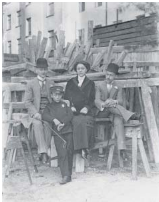
Rodzeństwo Ignacy, Władysław i Helena Rabęccy oraz być może inżynier kierujący budową, ul. Stalowa 8, 1912 r.
