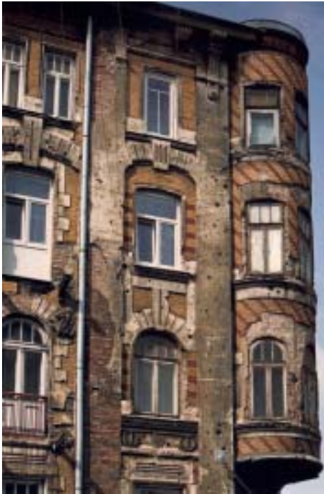
Kamienica "Pod sowami" przed remontem aut. zd. Jan Brykczyński
